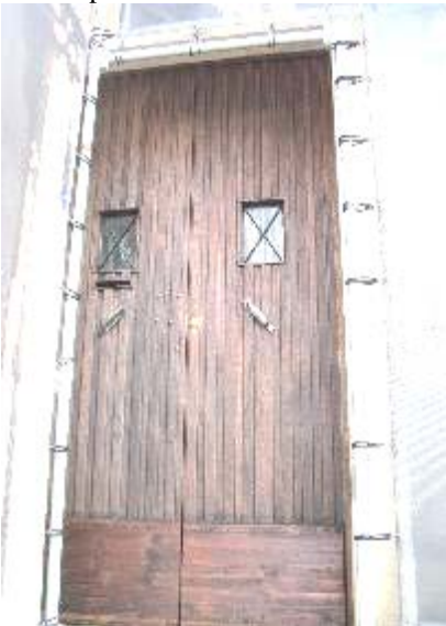
La porta dell'Asilo restaurata
