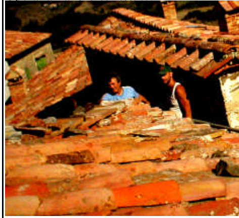
Operai al lavoro sui tetti...
